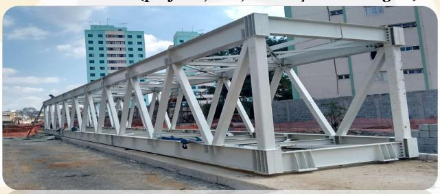
Realizamos todo trabalho de acompanhamento dos projetos para fabricação. Foco na compra dos materiais e no planejamento e controle da produção (PCP). Realizado montagem da estrutura da passarela na fabrica do nosso cliente para aferição e montagem da estrutura da passarela na obra para instalação.
