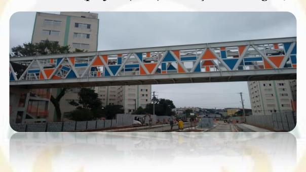
Montagem final da passarela sobre as cabeças dos pilares de concreto.
